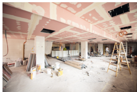
STAVEBNÉ PRÁCE NA OAIM
